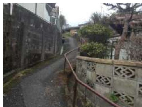
10 町道寺口・旭町線 手すり改修・すべり止め舗装等（町）
