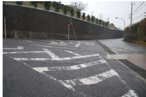
06 町道中央線（公民館南） 交差点改良（町・公安委員会）
