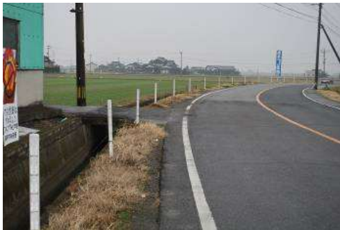
01 町道本町・馬田橋線 路肩拡幅（町）
