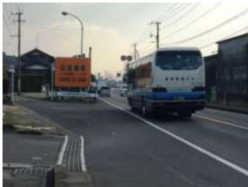
09 国道 34 号線（中島区付近） 交差点改良（町）
